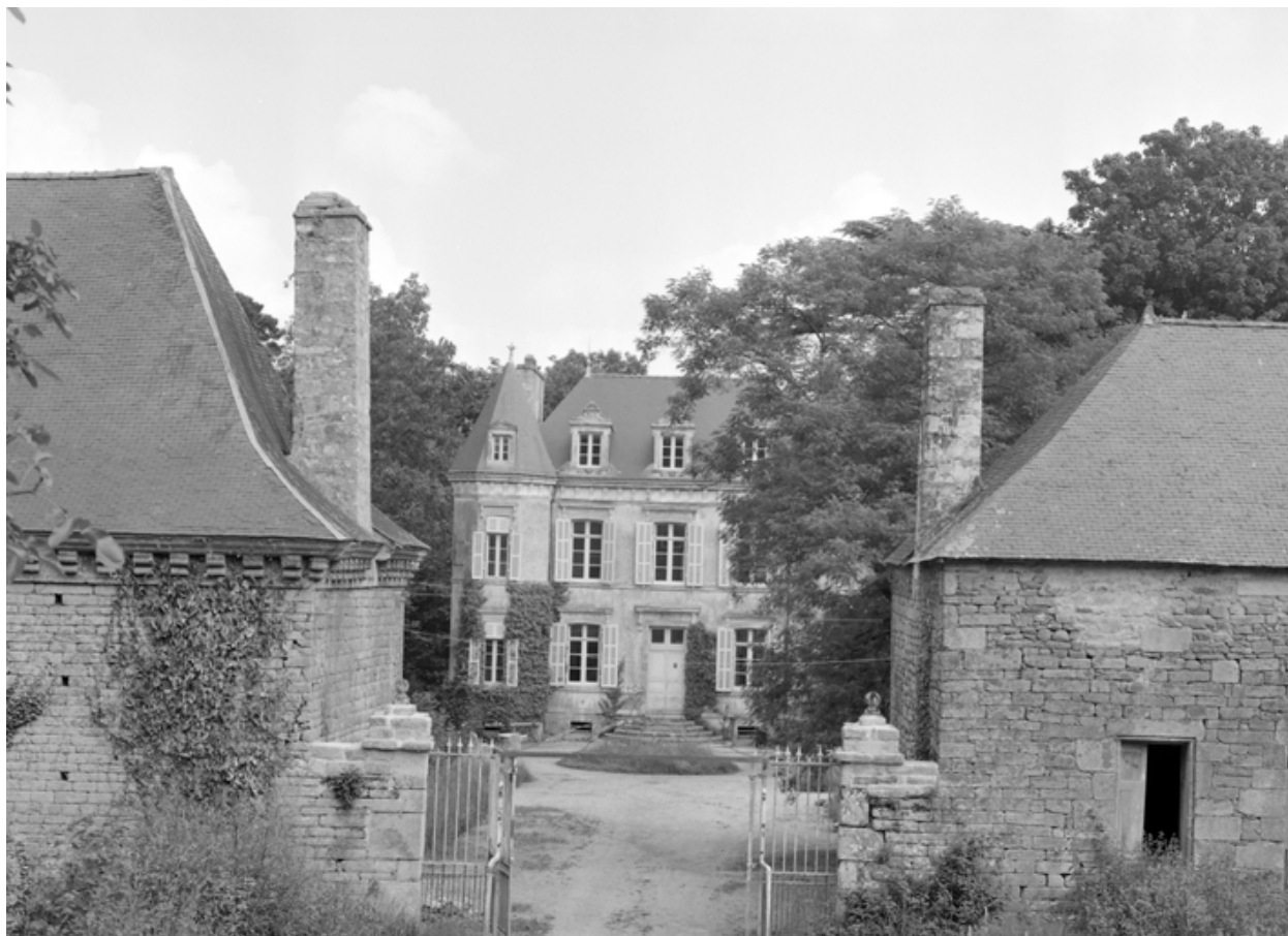
Portail d'entrée sud.
