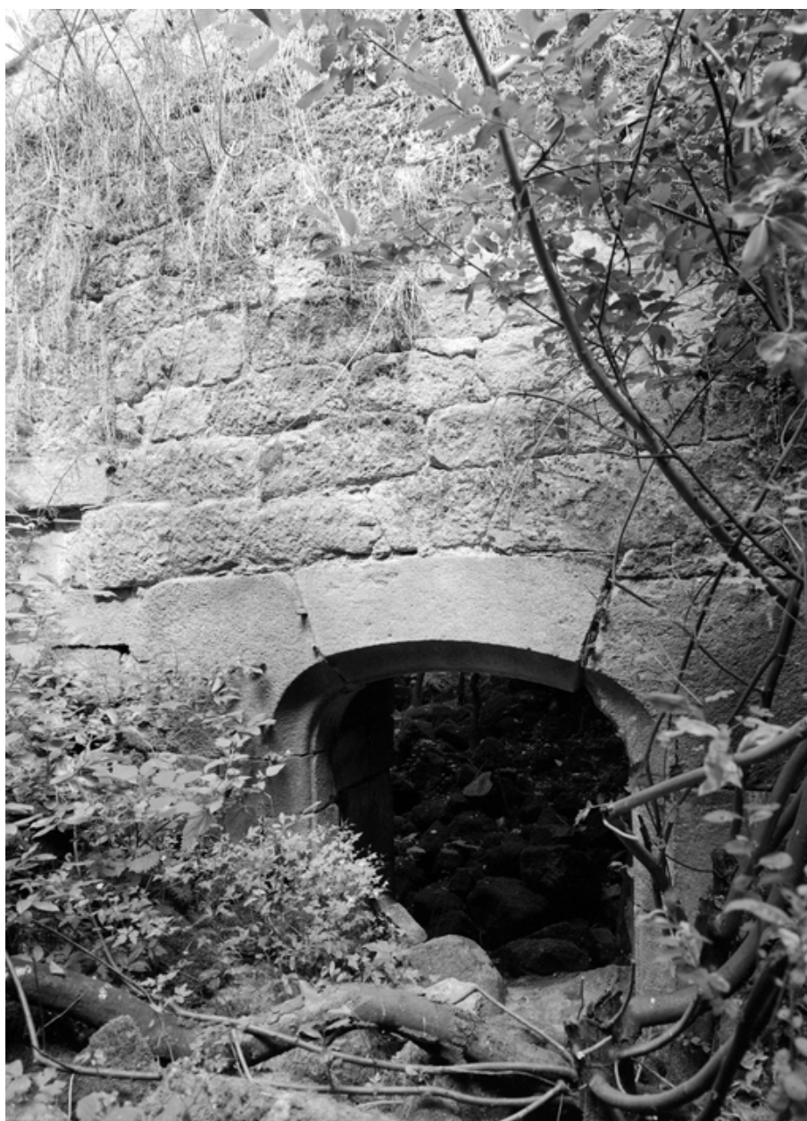
Porte du mur de refend ouest du manoir XVle, état en 1967
