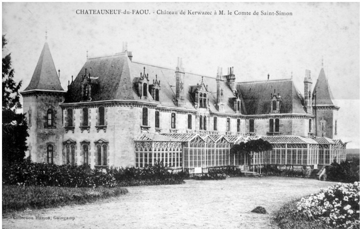
Vue de trois-quart sur la façade sur jardin (Archives départementales d'Ille-et-Vilaine, 6 Fi Saint-Goazec)
