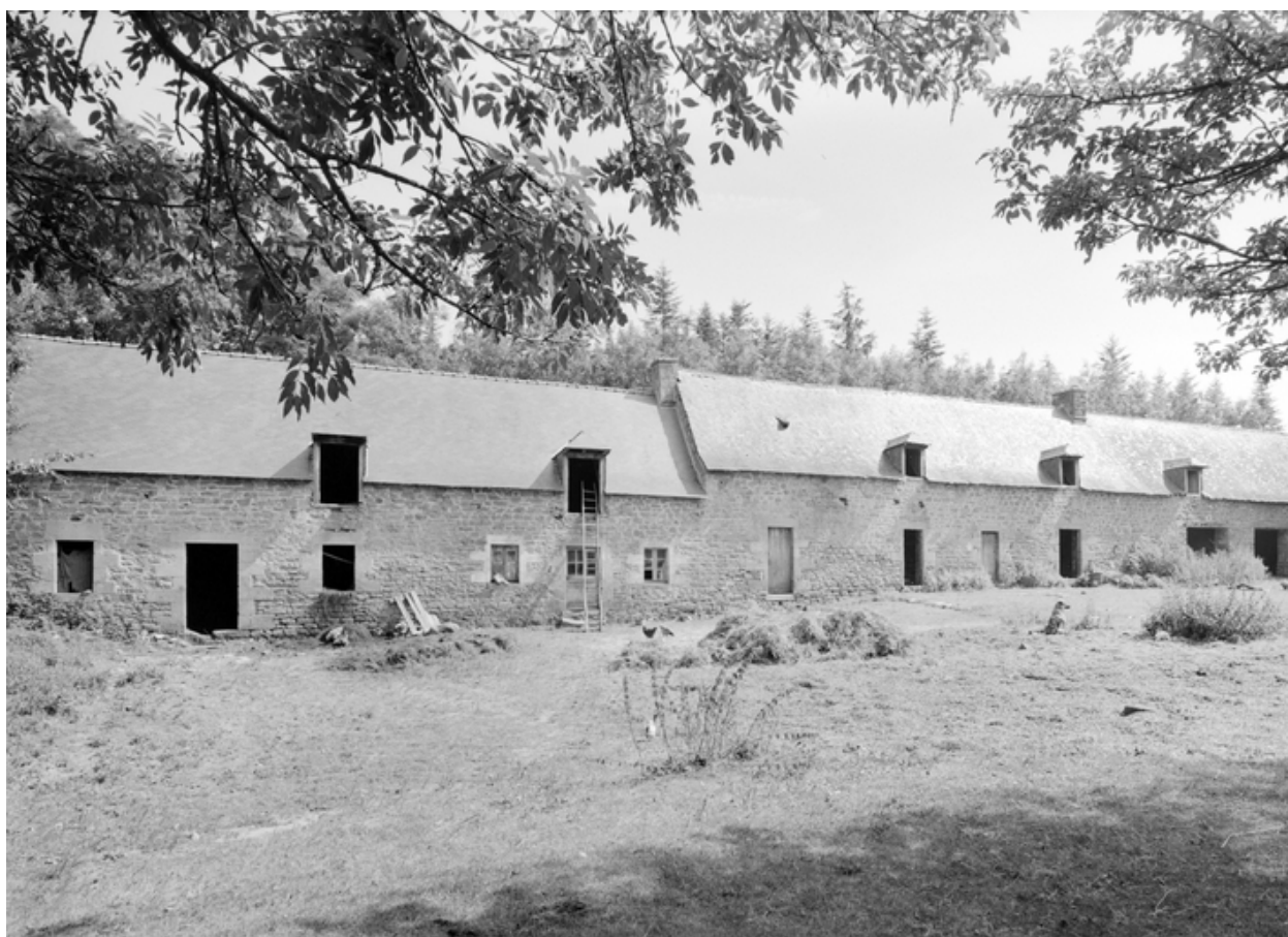
Communs ouest, vue générale, état en 1967
