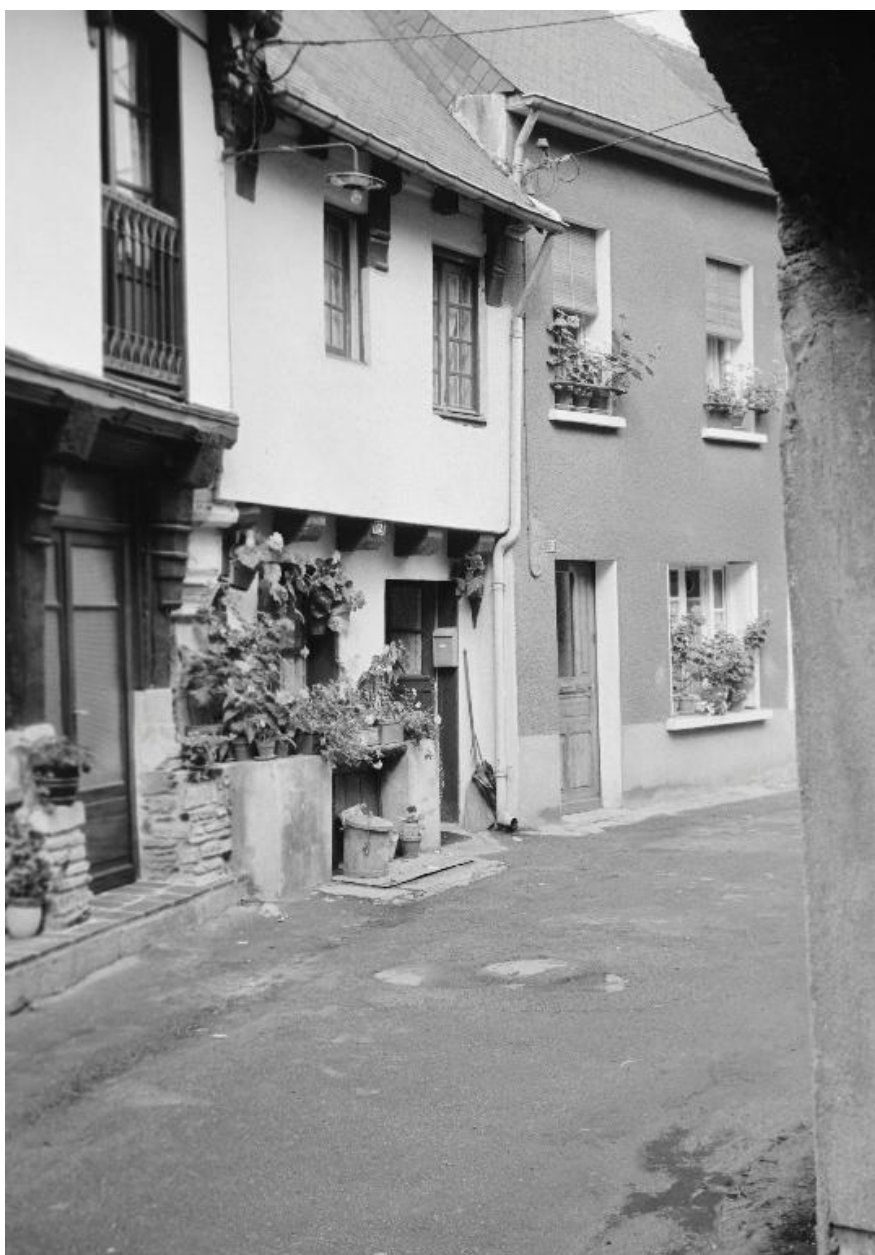
Maison : élévation est (état en 1969)
