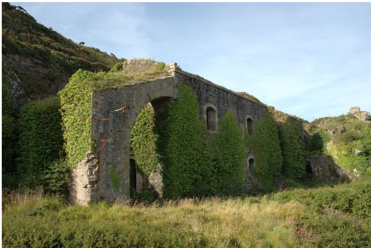
Vue générale de la caserne défensive Robert
