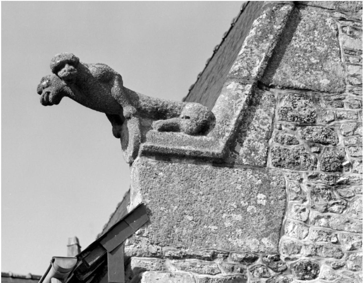
Pignon est, détail crossette, côté sud
