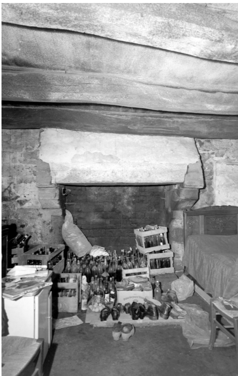
Rez-de-chaussée : vue de la cheminée du pignon ouest
