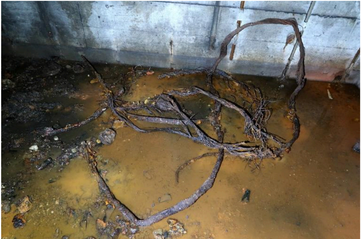
Vue intérieure : salle de garde sud, câble et divers artefacts rouillés
