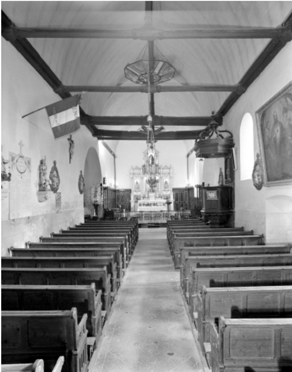
Intérieur : vue générale vers le chœur.
