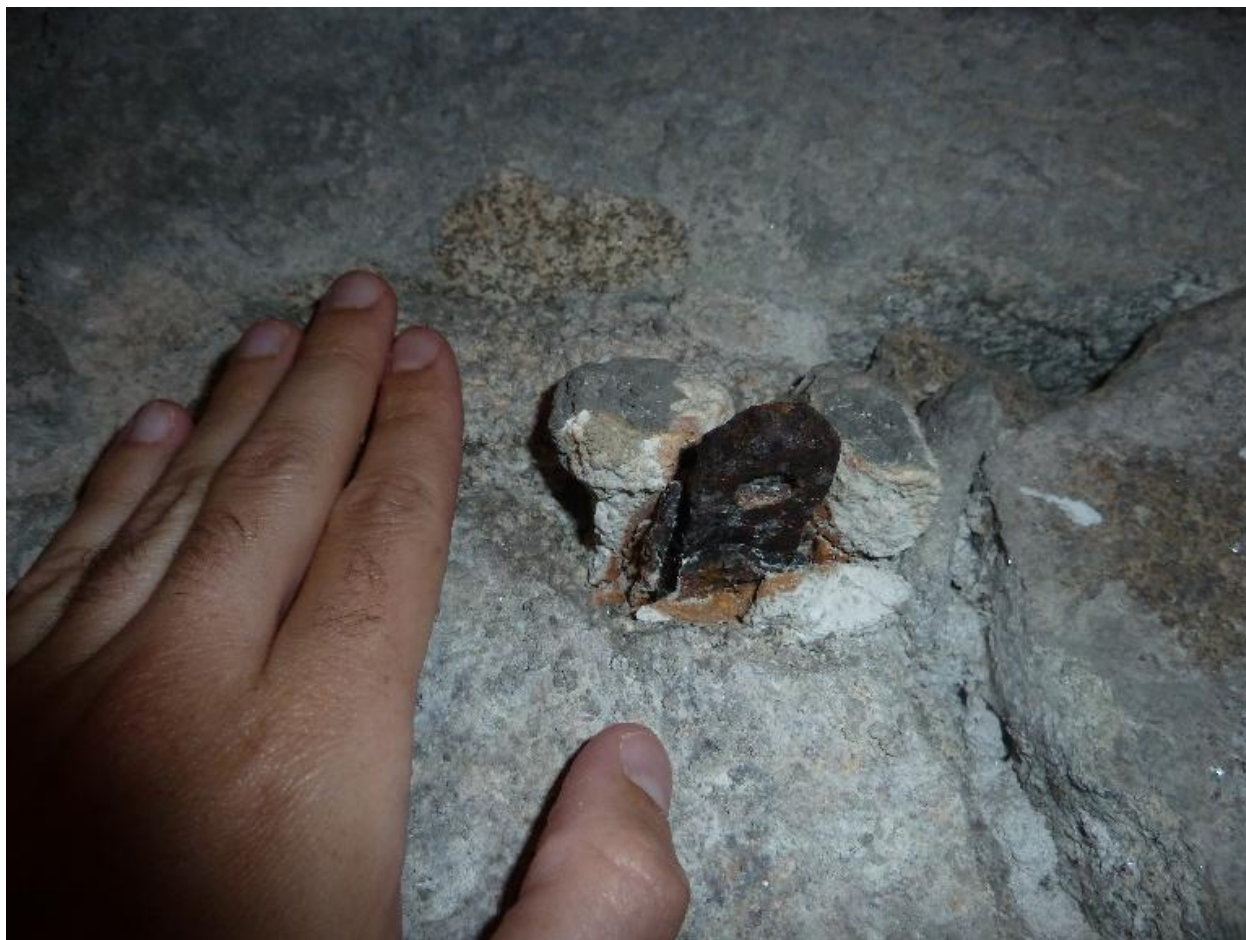
Hœdic, fort central, caserne à l'épreuve, détail de piton de planche à bagages.
