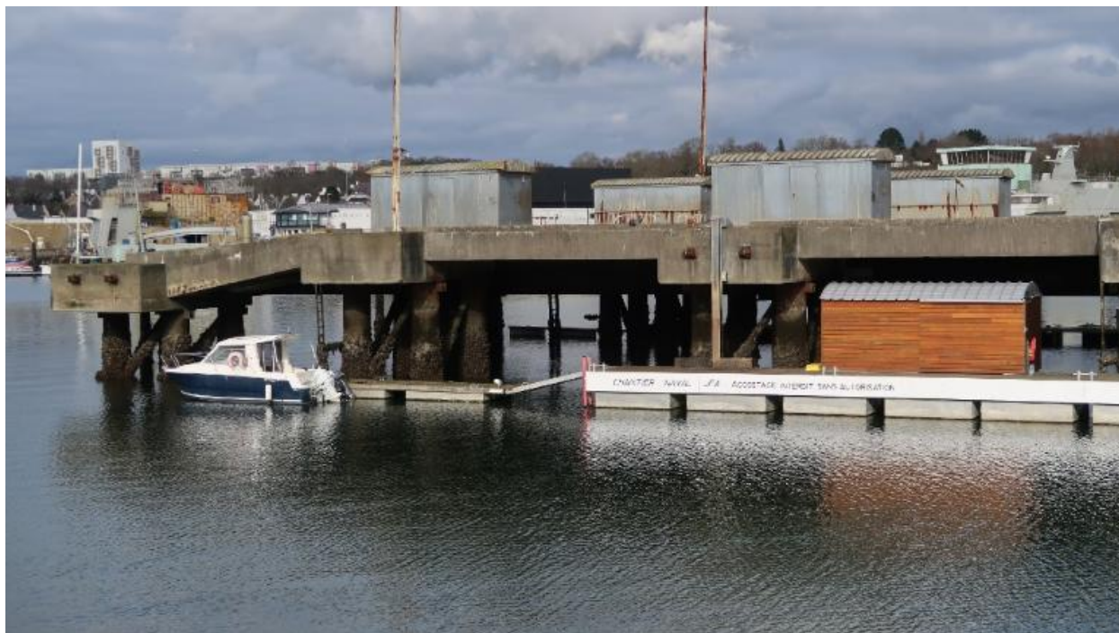
Aire de réparation navale : chantier JFA
