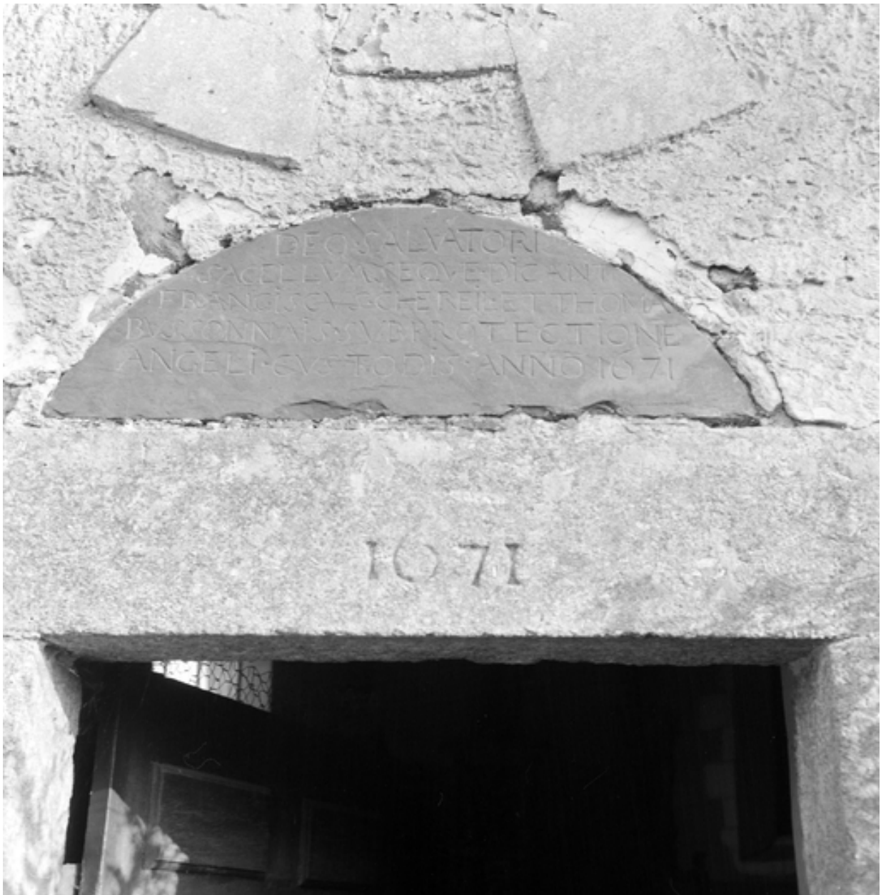
façade nord, vue de détail du linteau et de l'inscription.
