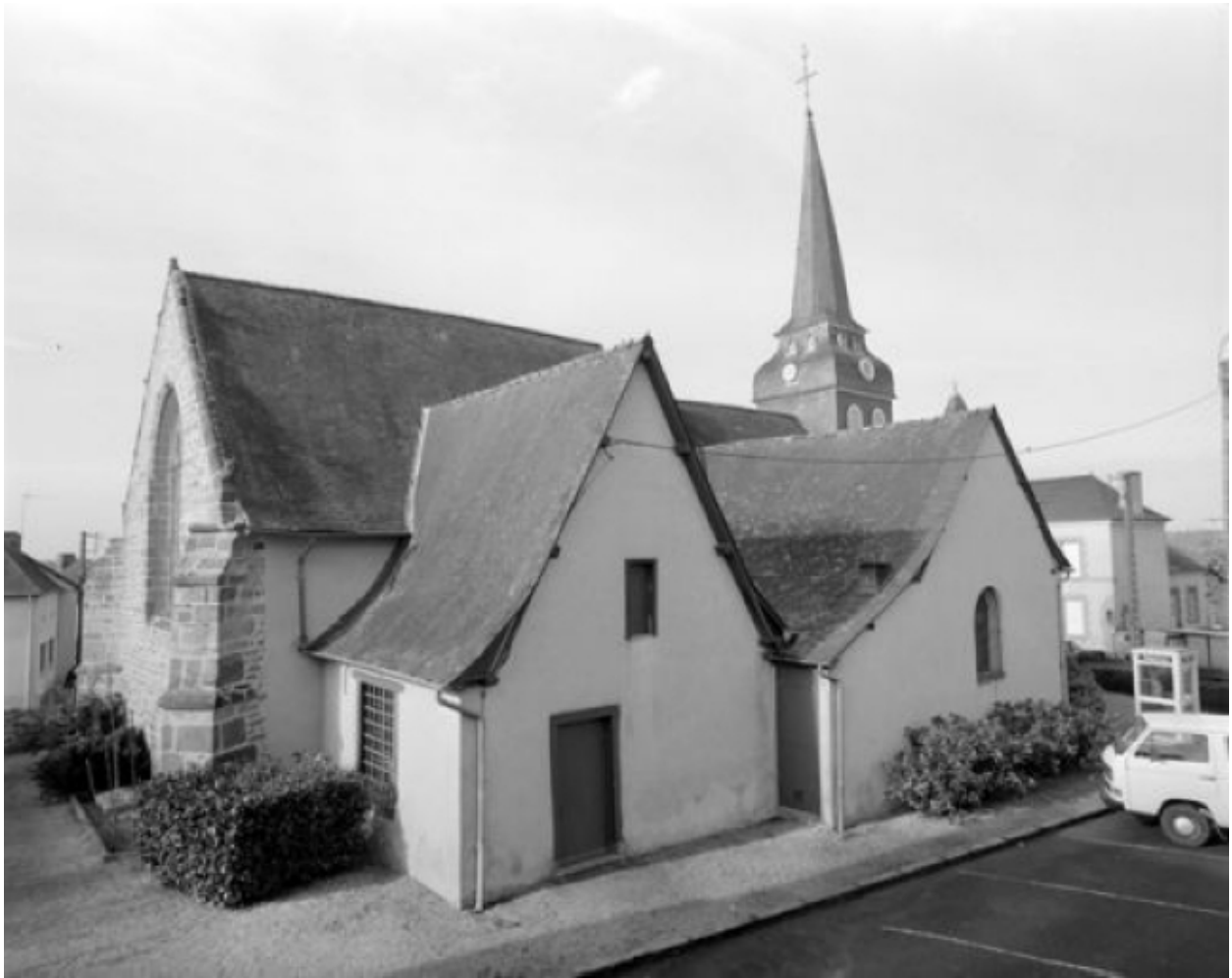
Elévation nord-est : vue générale
