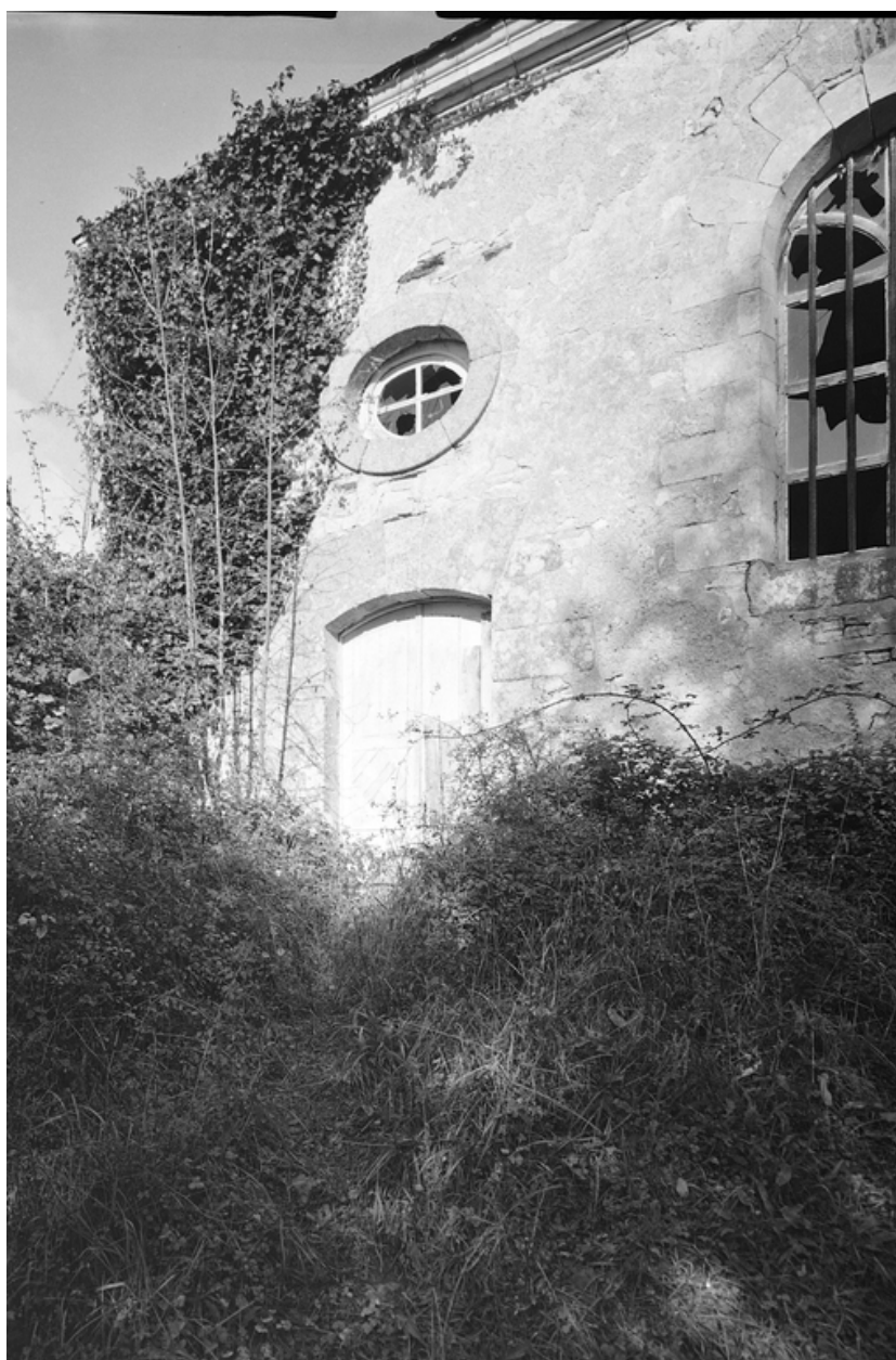
Chapelle, élévation sud, vue de détail des ouvertures.
