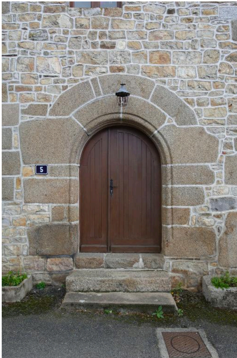
Détail de la porte en plein cintre située dans la partie nord de la nef
