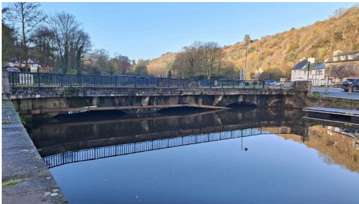
Le pont-de-pierre depuis le port de plaisance
