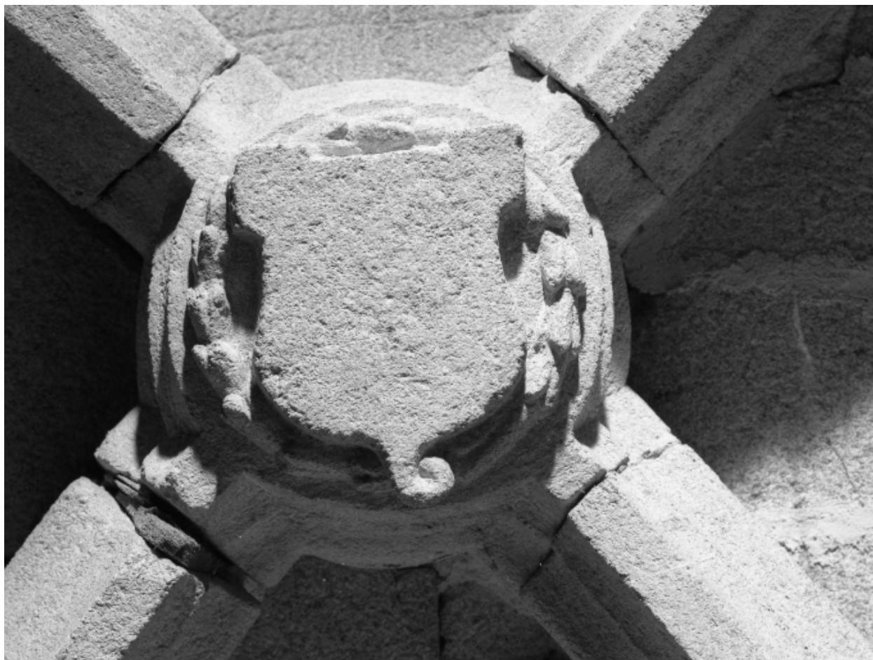
Escalier, 1er repos du rez-de-chaussée : détail de la clé de voûte
