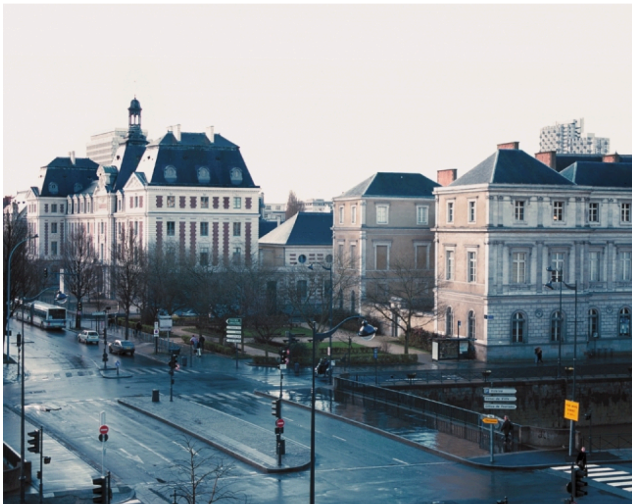
Vue biaise depuis le pont Pasteur
