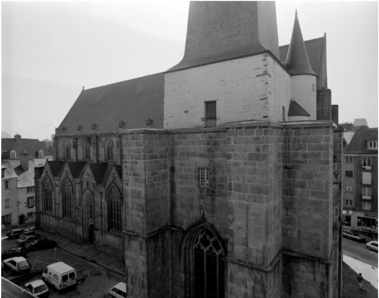
Elévation nord, vue générale.
