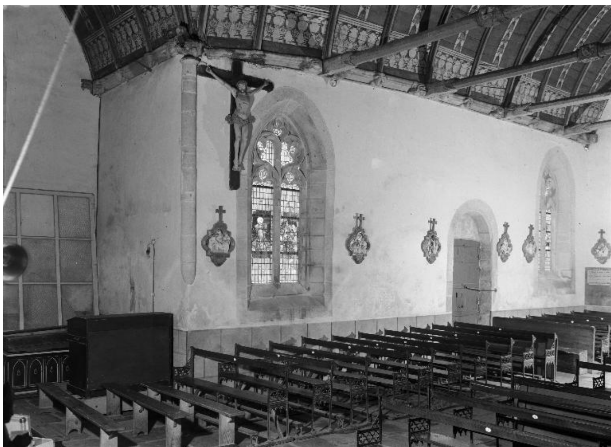
Nef : vue d'ensemble du mur sud
