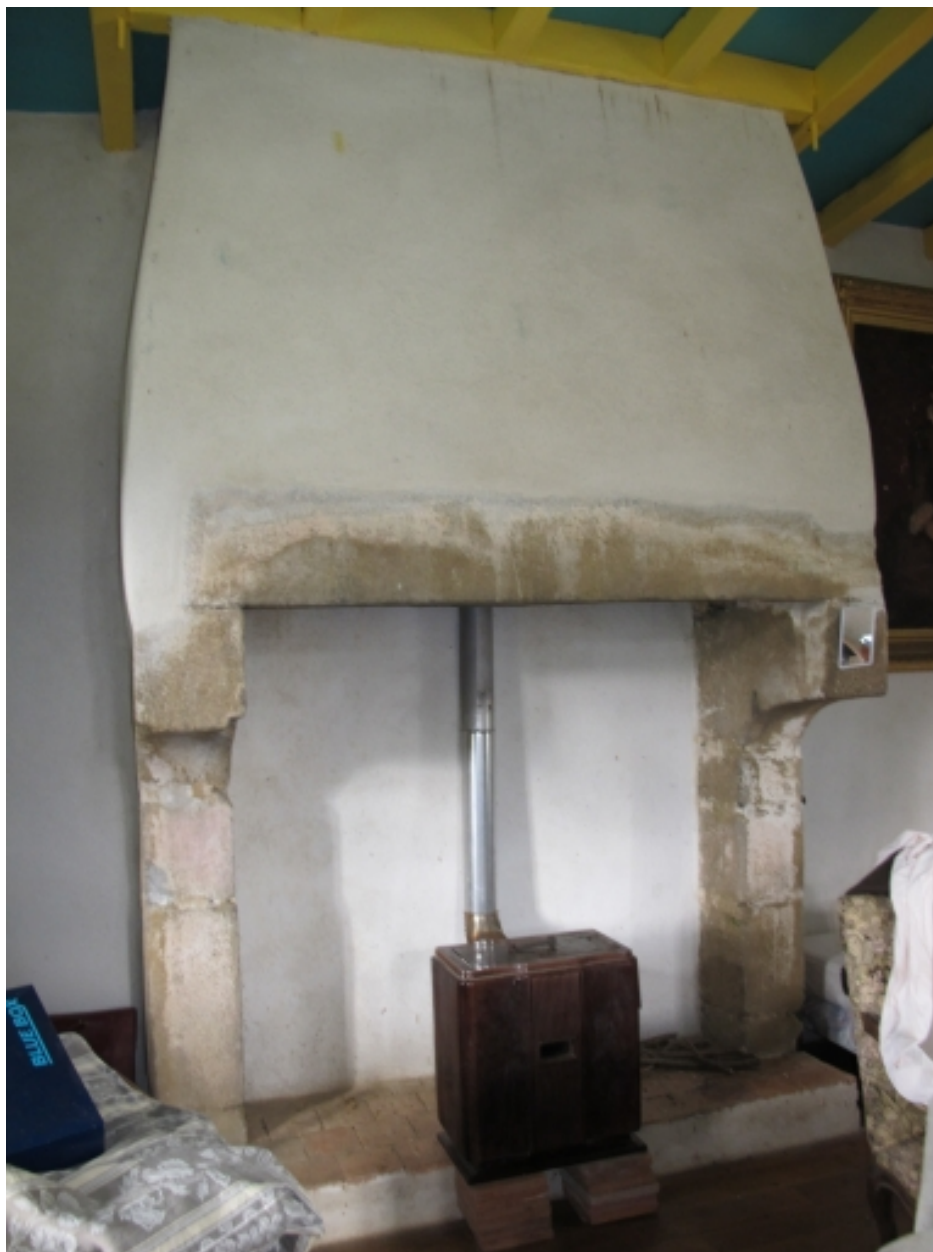
Cheminée située dans le bâtiment sud-ouest
