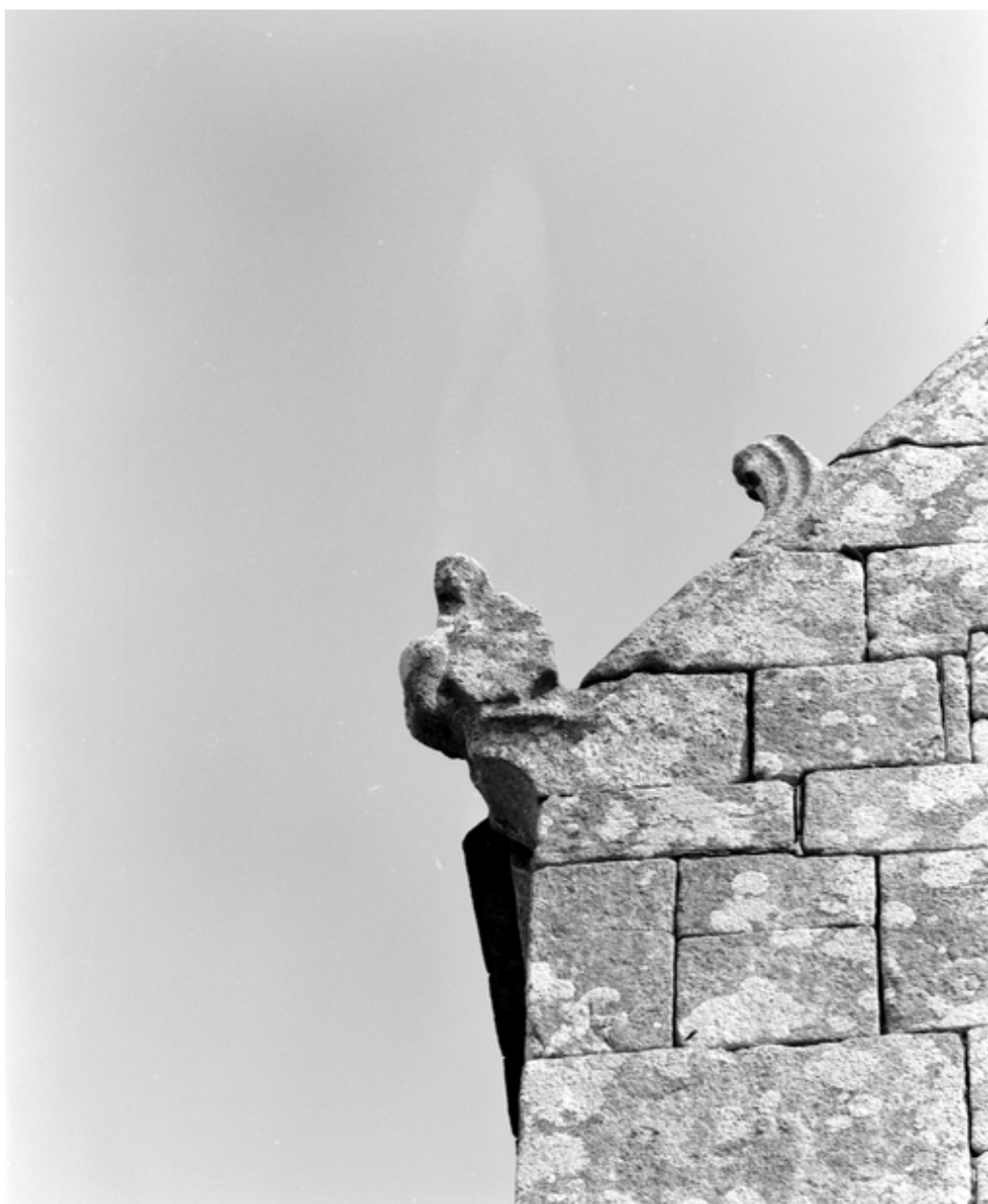
Porche, face sud : pierre d'assise du rampant ouest
