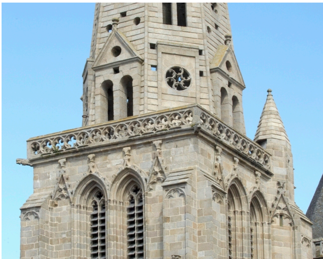
Détail de la tour des Cloches
