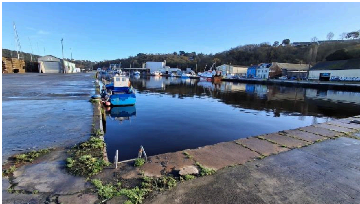
Vue générale du bassin Mézaubran
