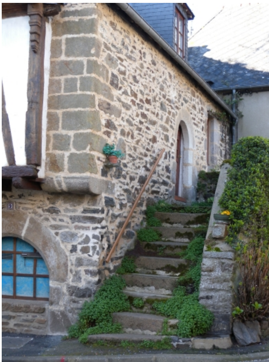
Vue de la façade avec escalier extérieur, rénovée et remaniée
