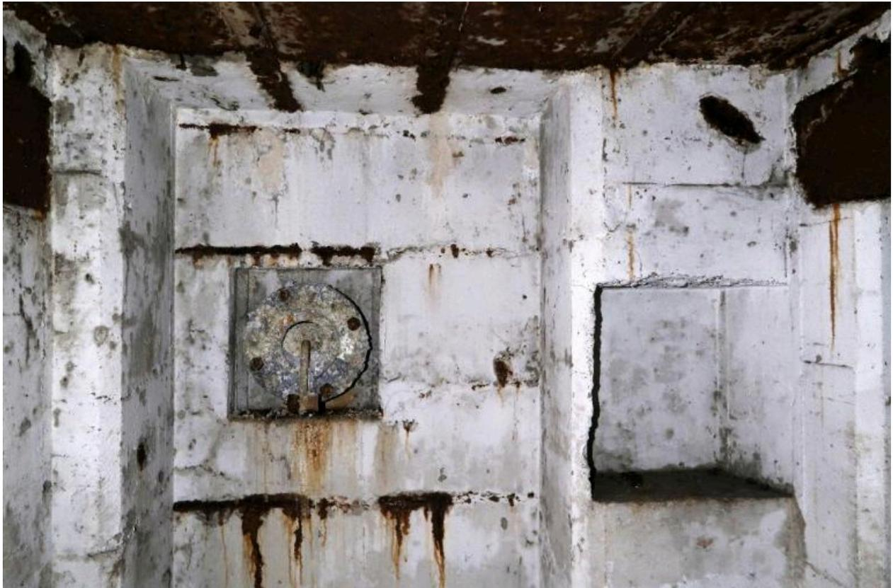
Vue du sas : mur est avec bouche de surpression à clapet à contrepoids en aluminium et niche murale. De part et d'autre se trouvaient deux portes blindées
