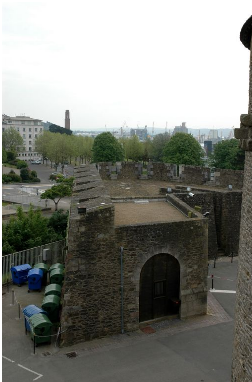
Vue du ravelin (ouvrage extérieur)
