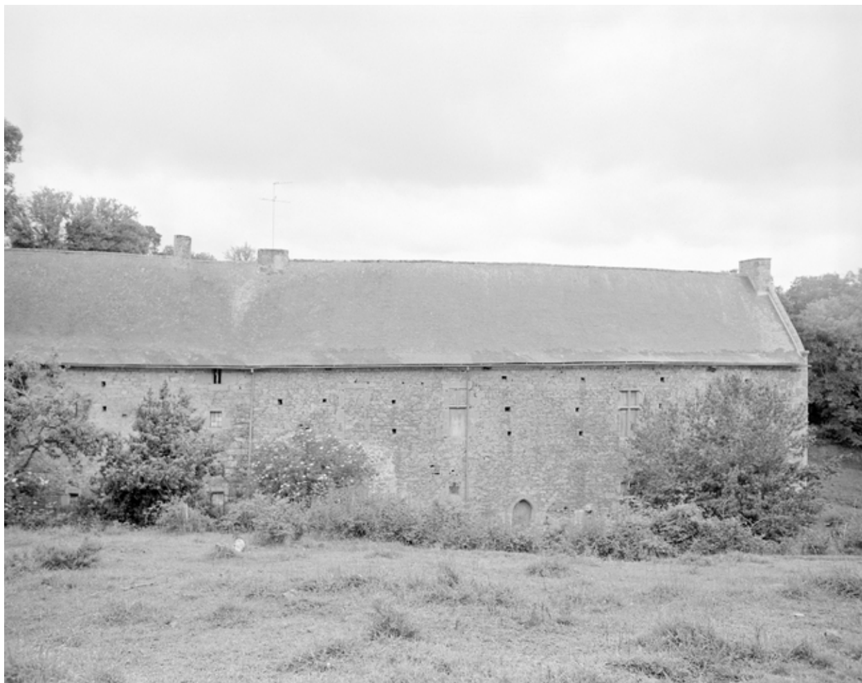
Elévation postérieure nord du logis. Etat en 1977.
