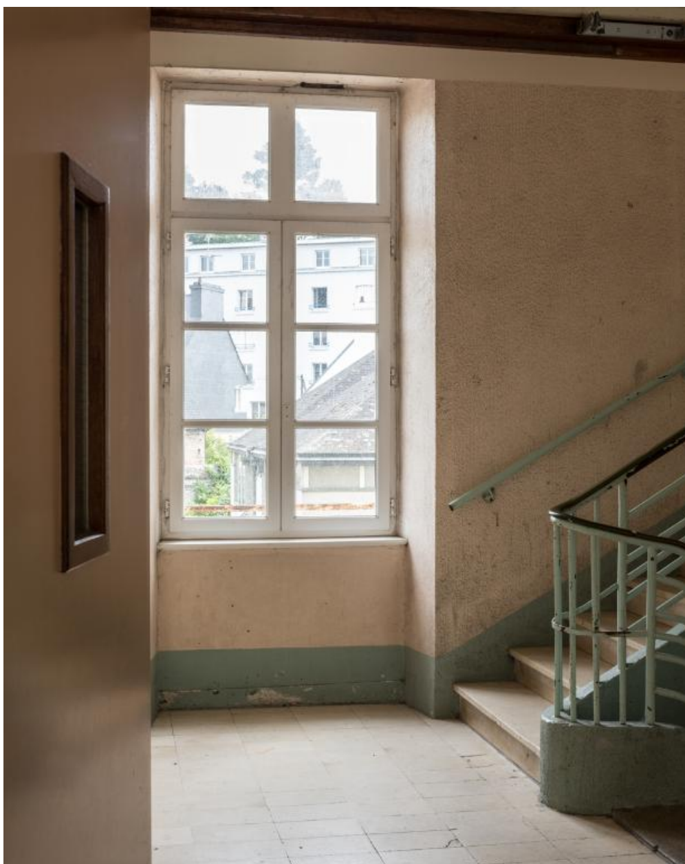
Cage d'escalier dans l'ancien séminaire réhabilité (vers 1950-1960).
