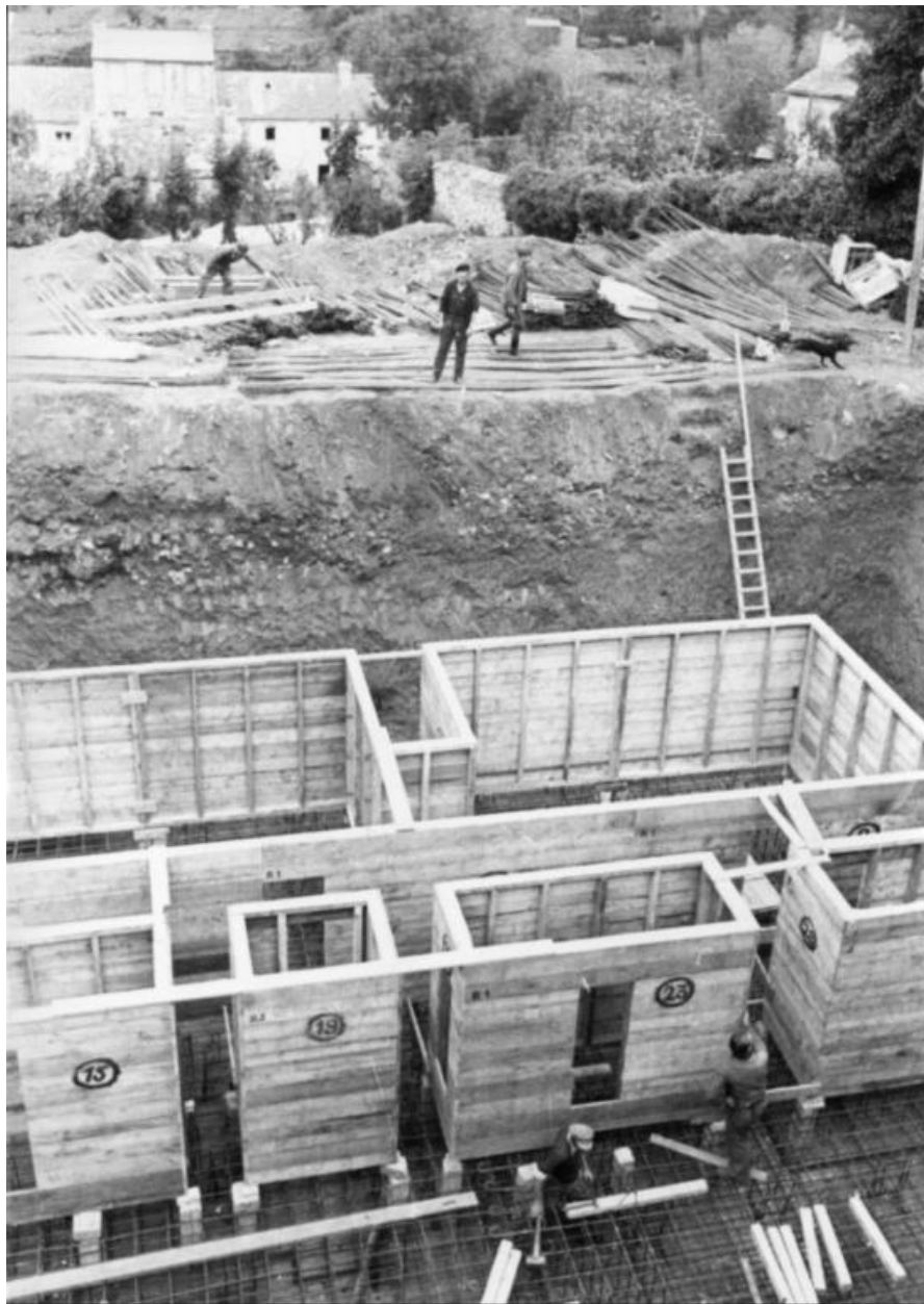
Vue du coffrage du bunker - abri de type 502 situé à proximité du poste de commandement de type 117a
