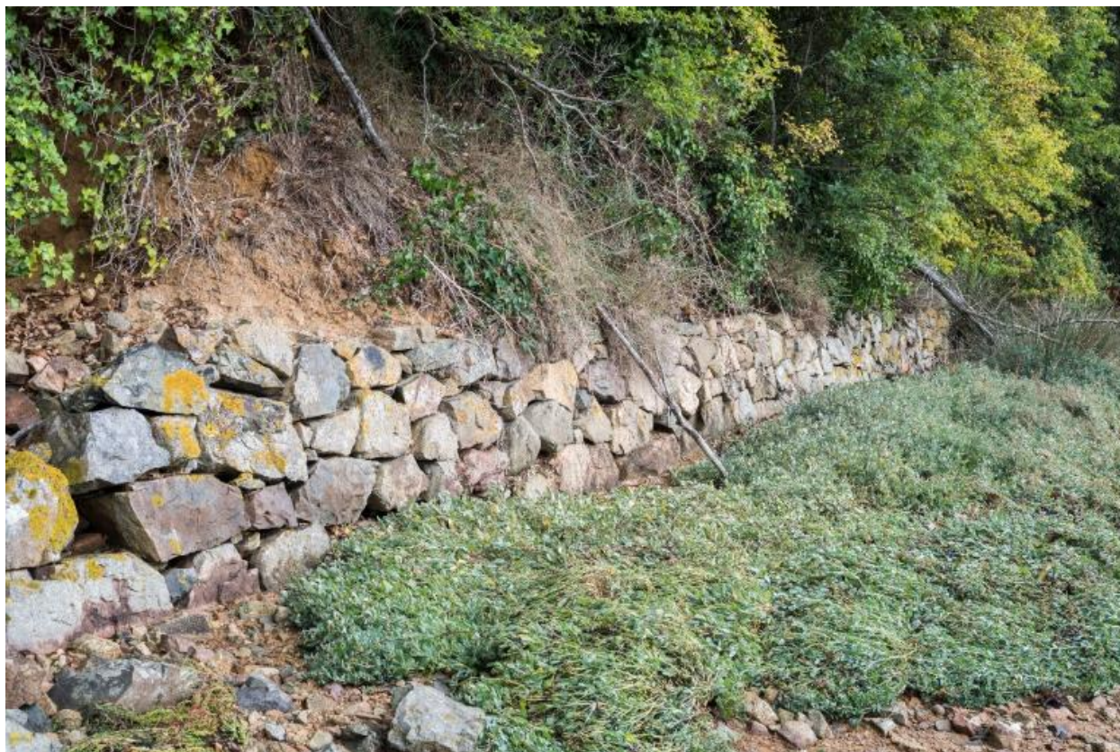
Mur de soutènement bordé par de l'obione ( Halimione portulacoides ), sur la rive ouest de la baie de l'Enfer
