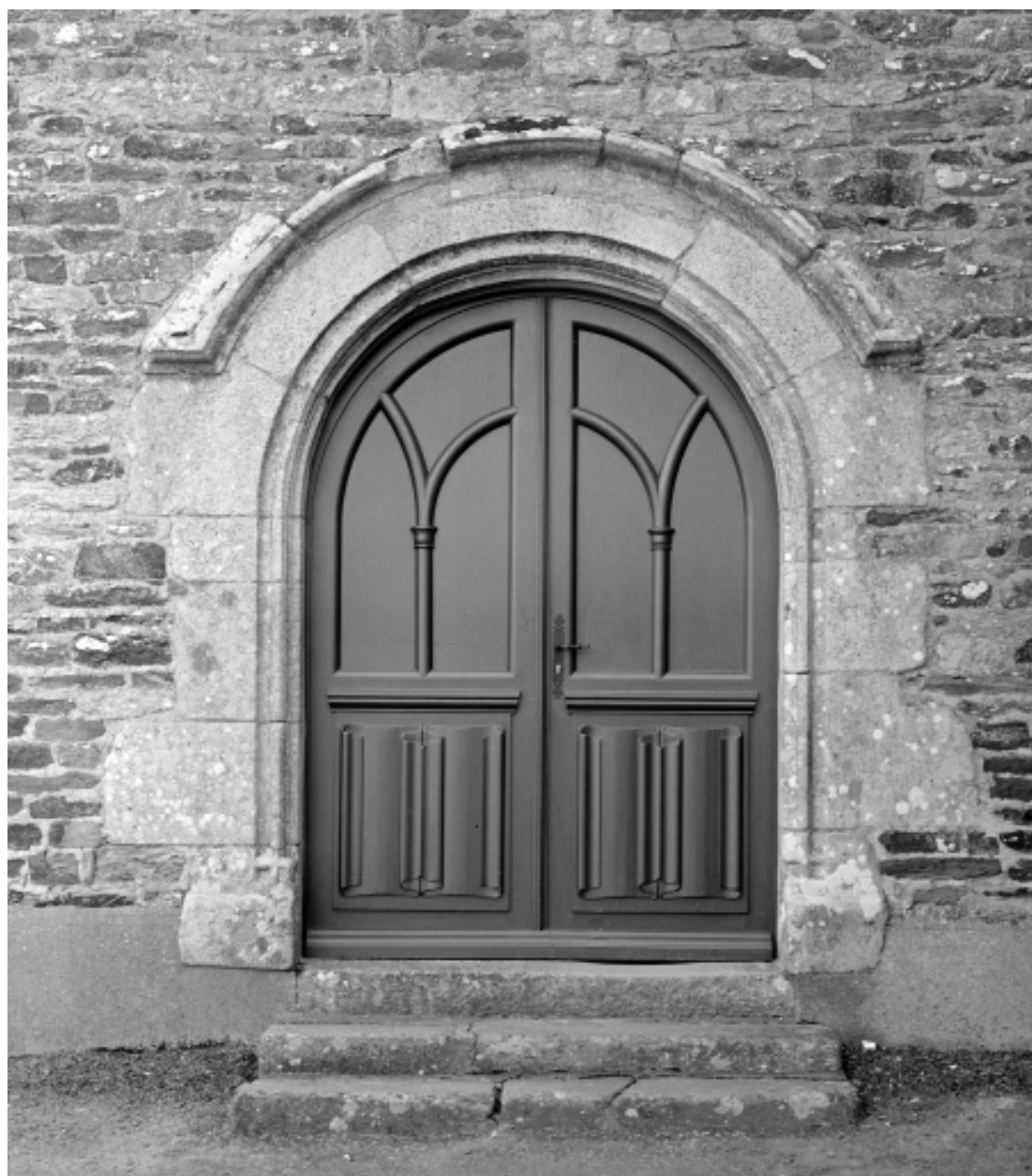
Elévation Sud, porte : vue générale
