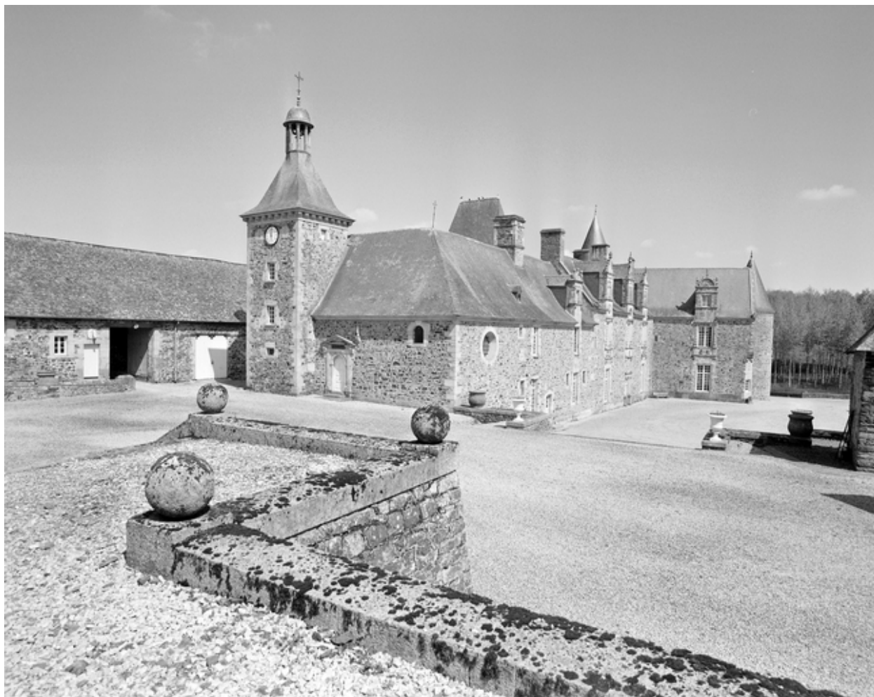
Château : vue sud-est.
