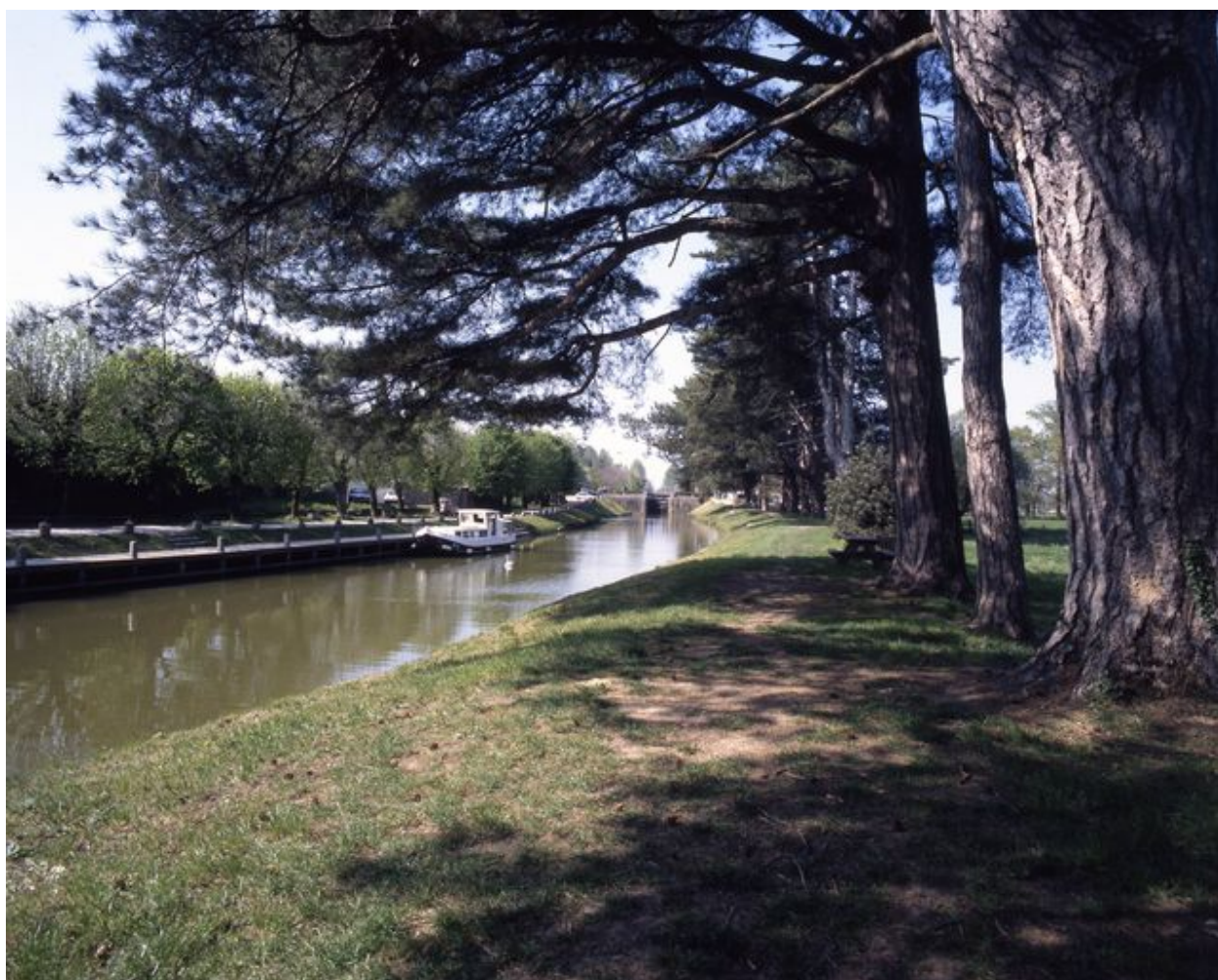
L'écluse de l'Hataie et le bief aval vus depuis l'aval (état en 1997)
