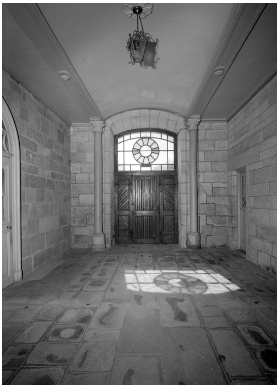
Corps de bâtiment B, entrée principale à l'ouest, ébrasement intérieur (1965)
