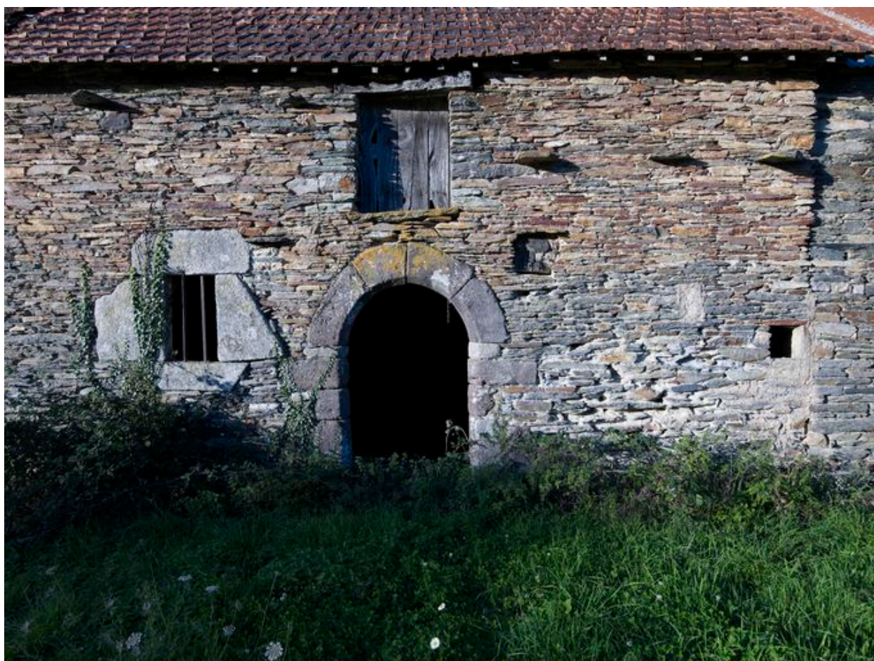
Le Coudray, ferme 1 : les baies (état en 2010)
