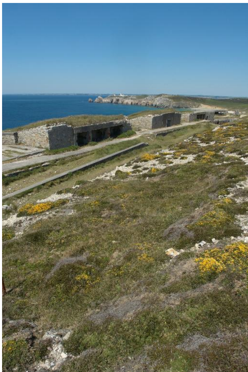
Vue de la batterie de mortier
