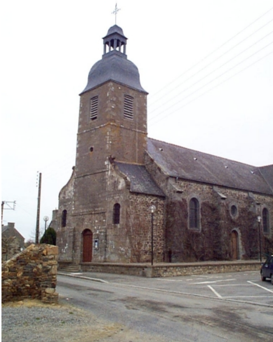
Clocher-porche, vu du sud-ouest
