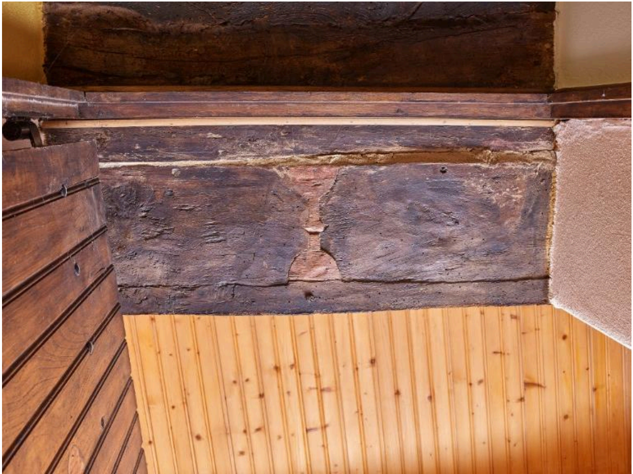
Logis principal. Porte de la chambre est. Remploi d'une poutre ornée d'un calice pour le linteau
