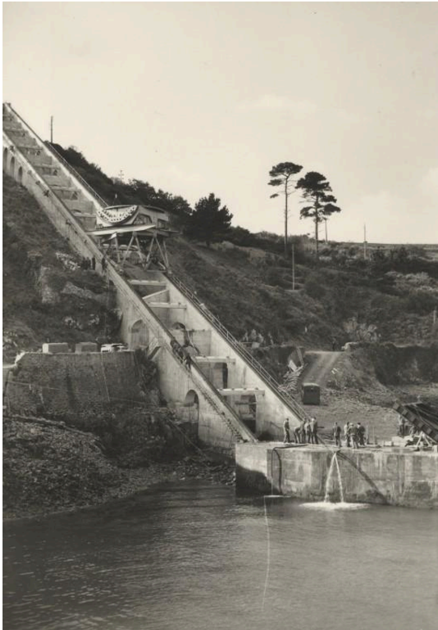
Vue de la rampe-funiculaire de la base d#essais de radiodétection en construction, 27 octobre 1964 (collection : Service historique de la défense de Brest : 2 U 8, n° 117). Sur la rampe, le chariot funiculaire et le chariot virole
