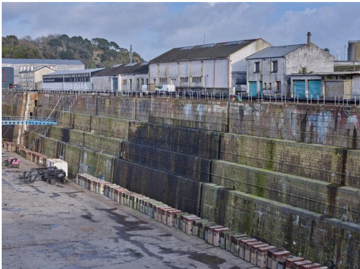
Bajoyer de la forme 1
