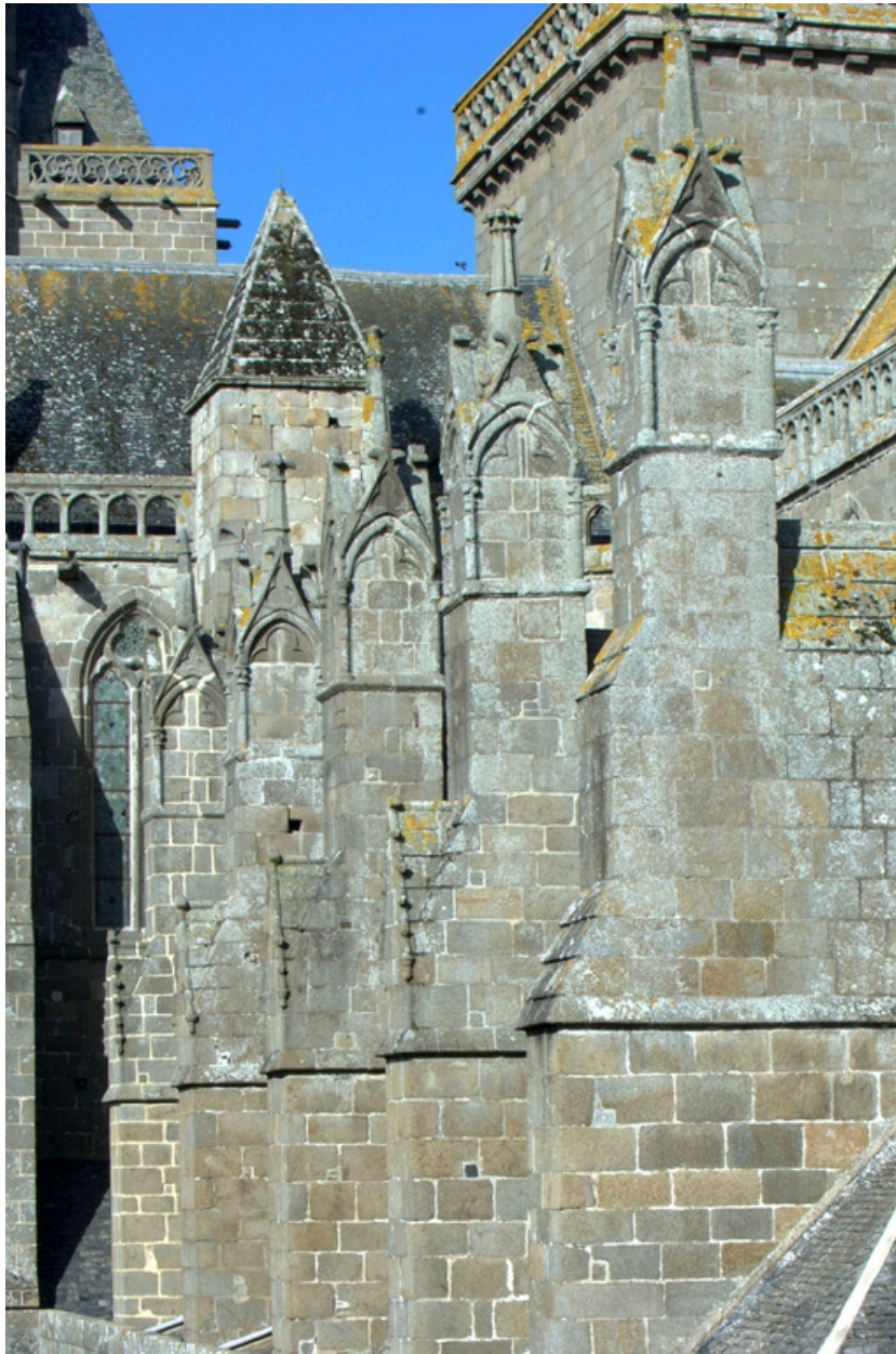
Pinacles des arcs boutants du côté sud du choeur
