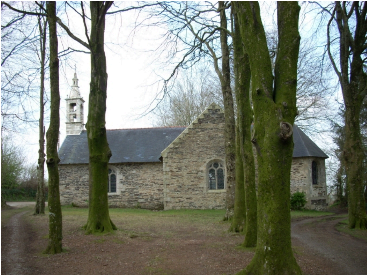
Briec, chapelle Notre-Dame d'Illijour : vue générale sud
