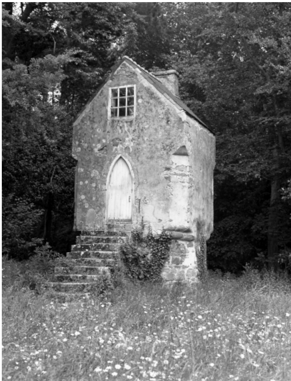
Ancien colombier au fond du jardin, vue générale sud-ouest
