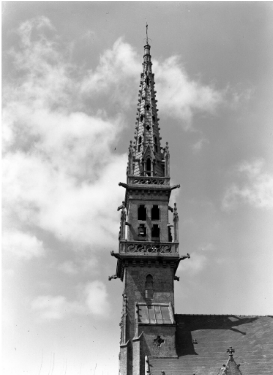
Plonévez-Porzay, église paroissiale Saint-Miliau : Clocher, vue générale, état en 1970
