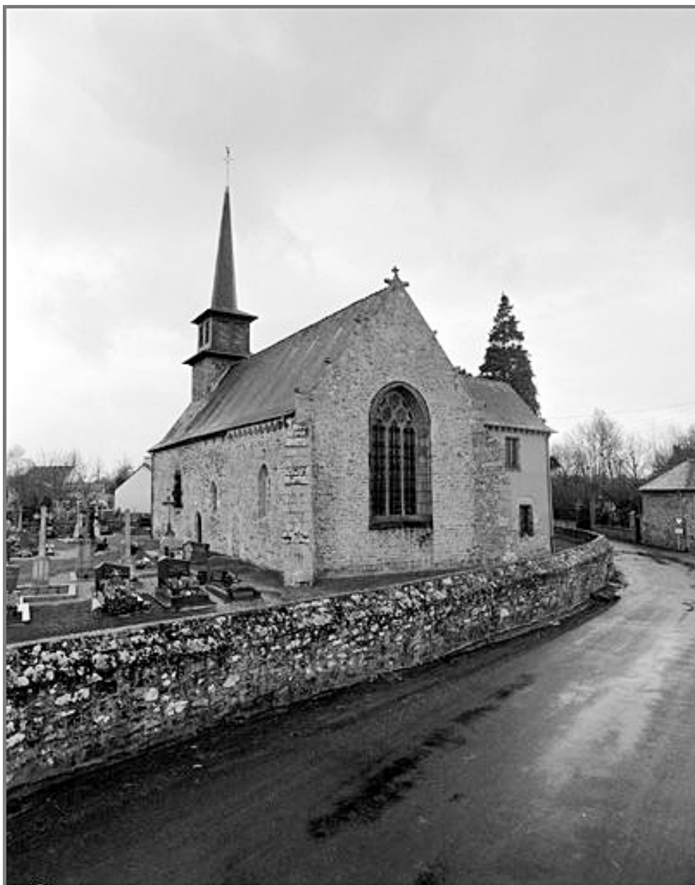
Elévation Est : vue générale
