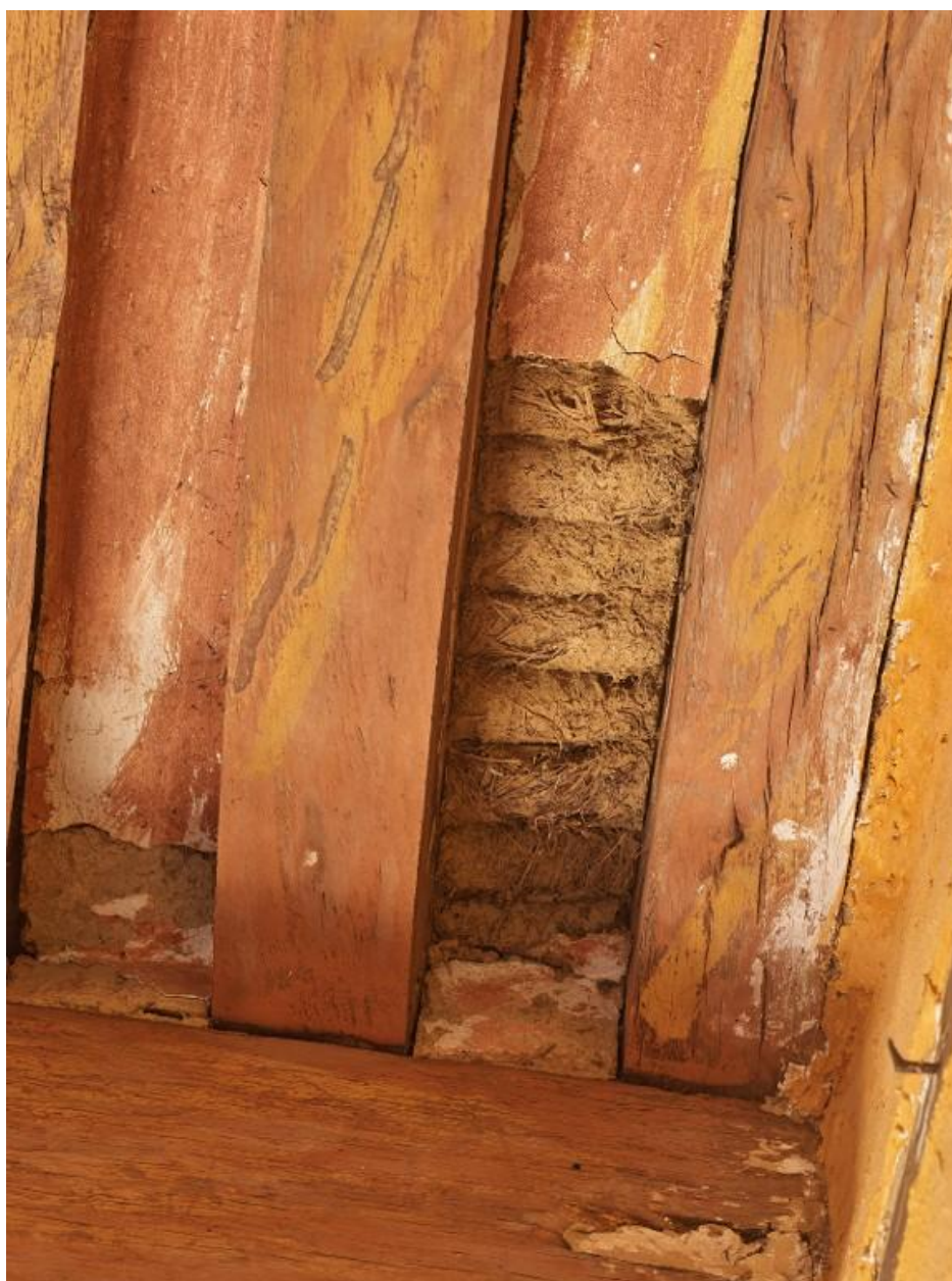
Isolation du plafond de l'étage avec des barasseaux
