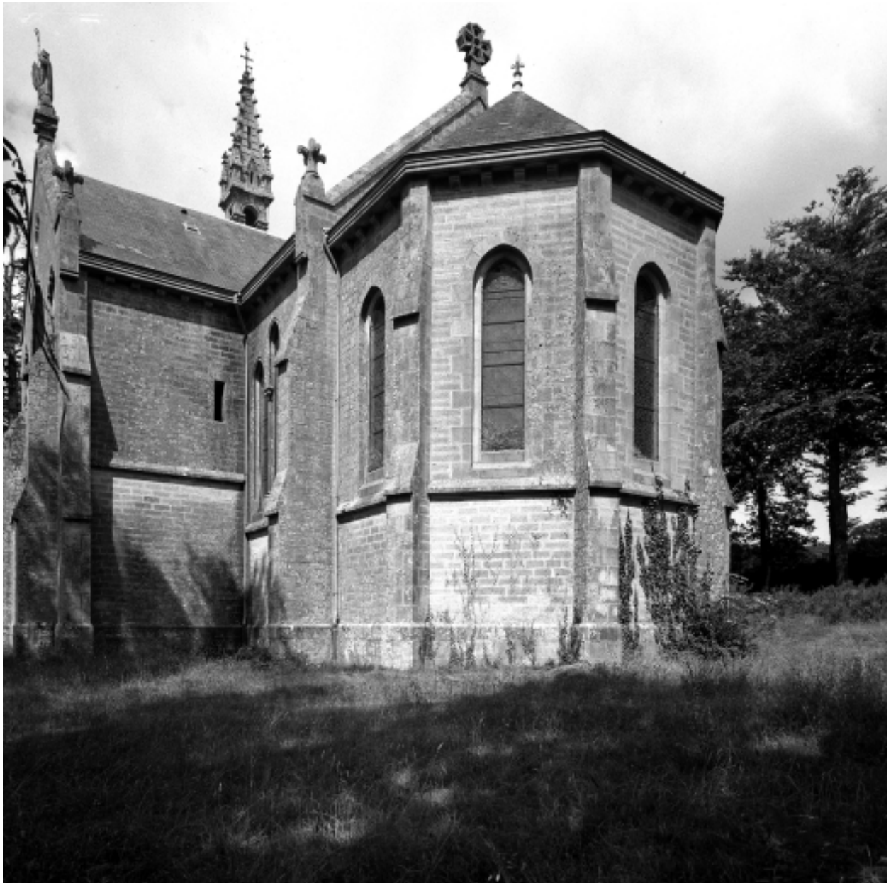
Plomodiern, chapelle Saint-Corentin : façade est, état en 1970
