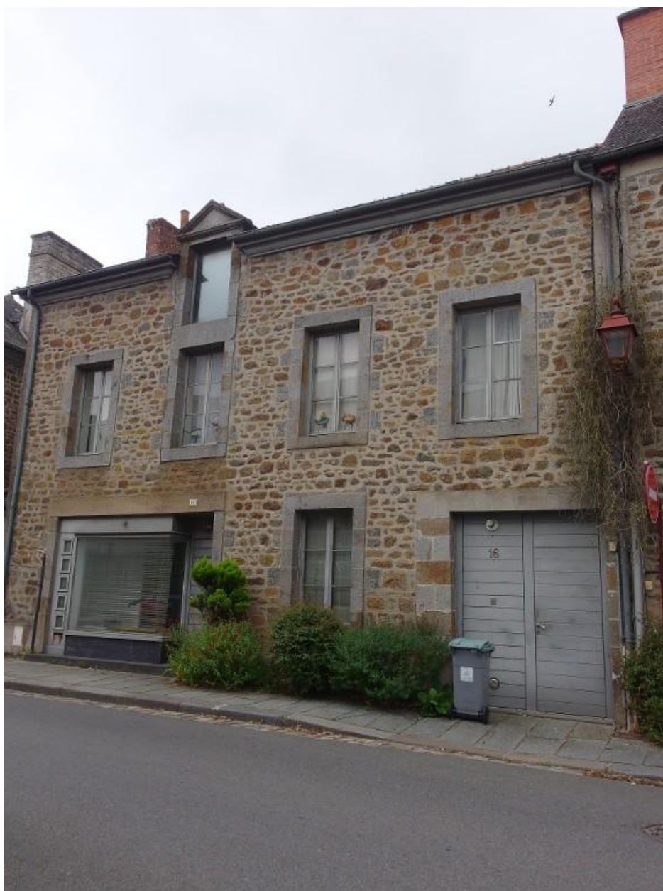
Vue de la façade est
